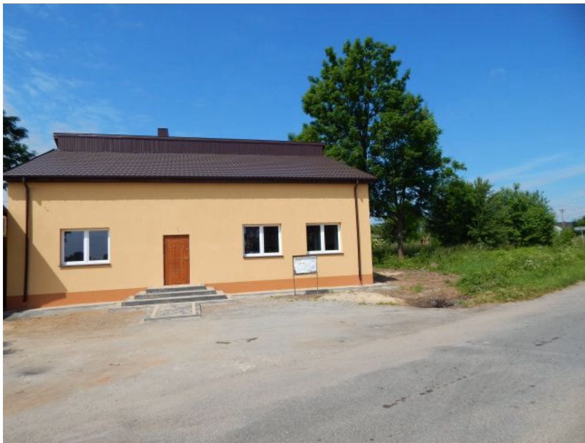
Fot. Zmodernizowana świetlica wiejska- Rdzów
