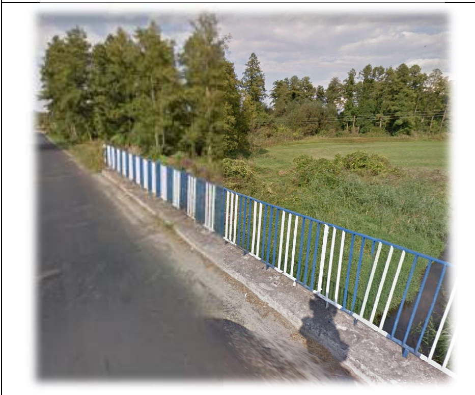
Rys. Widok miejsca planowanego wylotu ścieków oczyszczonych do rzeki Wiązownica
